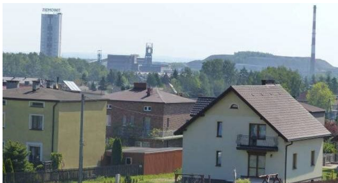
Widok na teren kopalni i hałdę z dzielnicy Łęczyny
